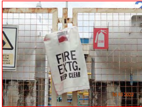
ภาพที่ 2.2-44 การติดตั้งถังดับเพลิงผงเคมีแห้ง บริเวณลานถังเก็บ LPG
