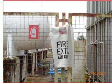
ภาพที่ 2.2-44 การติดตั้งถังดับเพลิงผงเคมีแห้ง บริเวณลานถังเก็บ LPG
