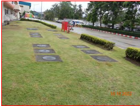
ภาพที่ 2.2-7 ระบบบำบัดน้ำเสียสำเร็จรูป แบบถังเกรอะ (Septic Tank)
